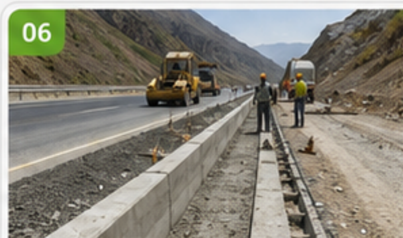
اجرای قرنیز بتنی جاده هراز
