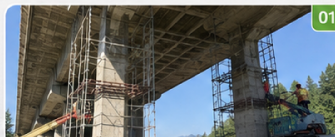
تعمیر و مرمت پل پلیس راه چلوس
