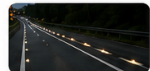
تابلوهای کنترل لاین و راهنمای LED راهنمایی مسیر در شب و شرایط نامساعد با دید بالا و مصرف انرژی کم
