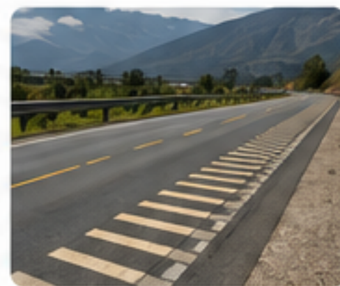
اجرای شیار لرزاننده و خط‌کشی محور کرج - چالوس
